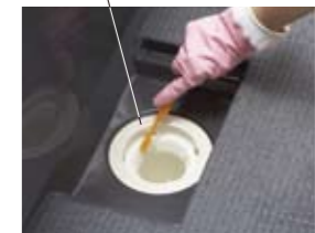
●排水トラップ本体
