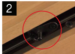
2 ファインモーション受けピン(枠上部)
